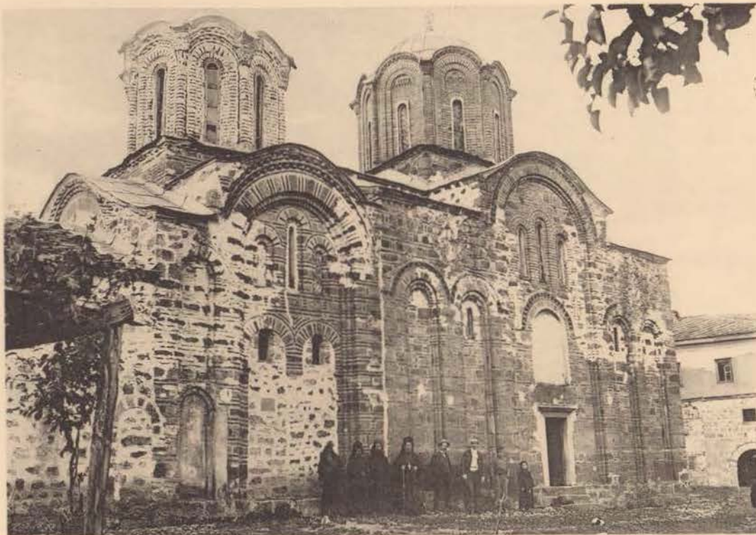
124. Lesnovo. Vue du nord-ouest.
